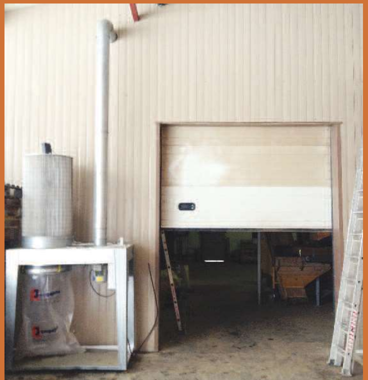
Brosseuse équipée d'une hotte d'extraction au-dessus et d'un bac de récupération de la terre en dessous. Un aspirateur à sac à l'intérieur du bâtiment canalise la poussière.
